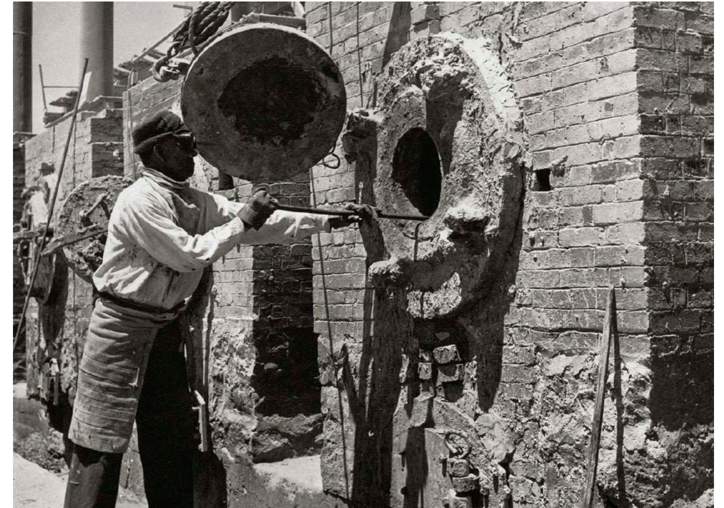
> Trabajador operando en una "retorta" para la obtención del yodo en una oficina salitrera. Worker operating in a "retort" to obtain iodine in a nitrate company.
