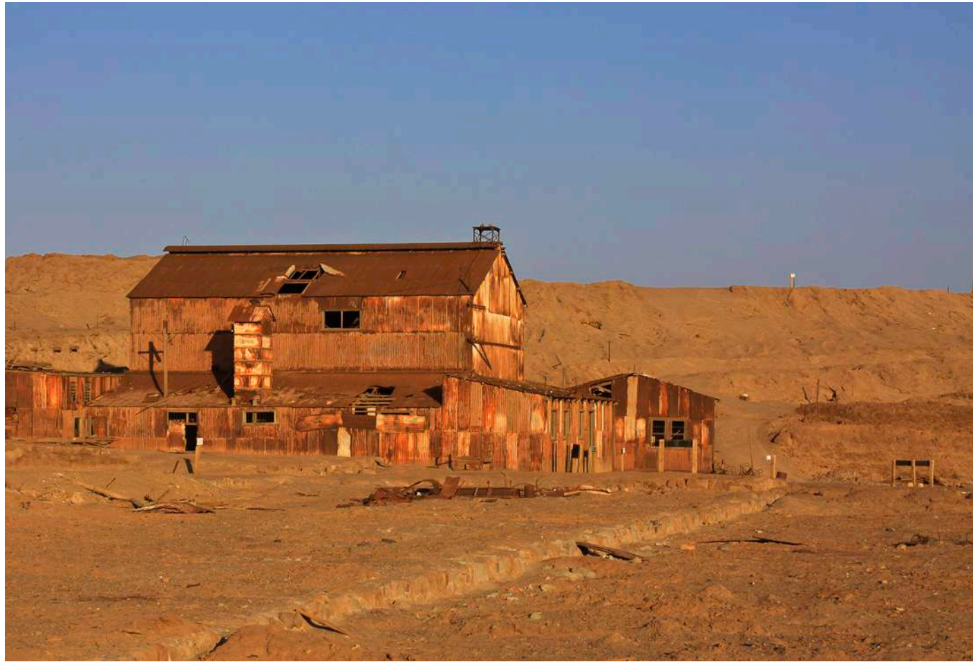
< Potencia para roer pampas, raer caliches y retrotraer al hombre. Casa de Fuerza. Force to eat away pampas, extirpate caliches and antidate Man. Power House.
